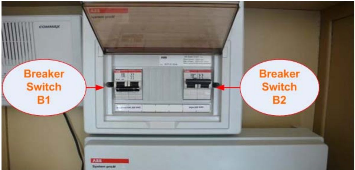
รูปที่ 3 แสดง ตำแหน่ง Breaker B1และ B2 เพื่อตัดต่อระบบไฟฟ้าจากการไฟฟ้าหรือ เครื่องกำเนิดไฟฟ้า
