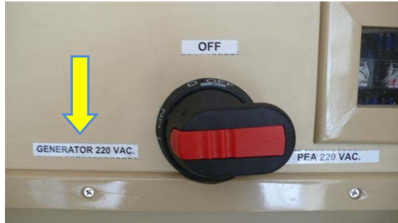
สวิทช์ถูกเลือกไปยังเครื่องกำเนิดไฟฟ้า (GEN)
