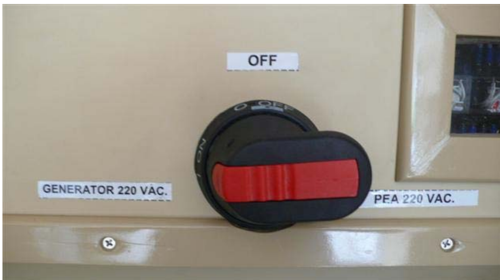
รูปที่ 2 แสดง Selector Switch (SW1) เพื่อเลือกการใช้ไฟฟ้าจาก การไฟฟ้า หรือ เครื่องกำเนิดไฟฟ้า
